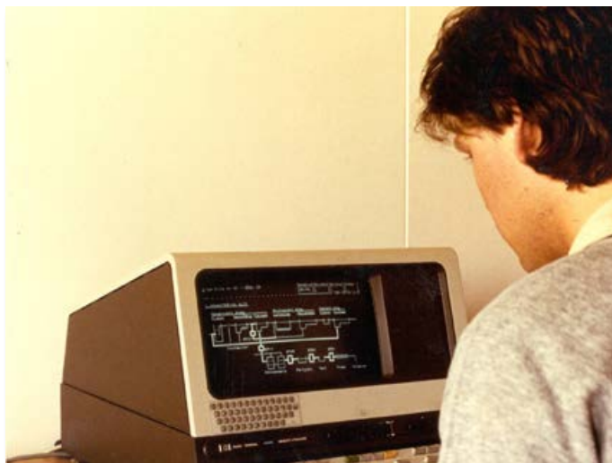
En av maskinisterna under manövrering på operatörsstationen.
