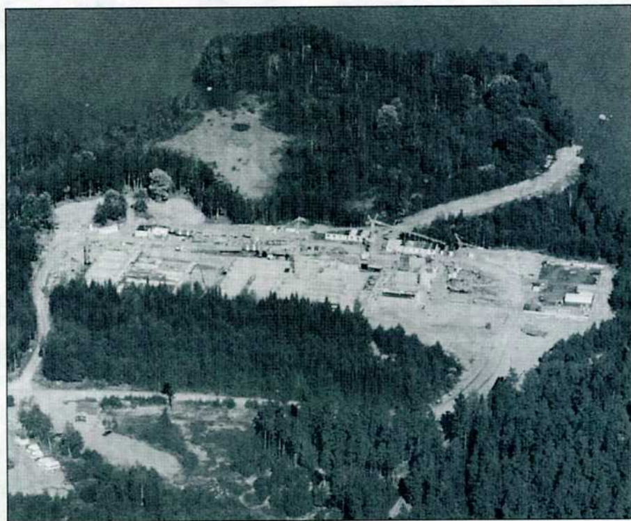
Sundet avloppsreningsverk i september 1993 med Norra Bergundasjön i bakgrunden.
